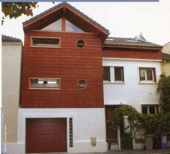
briques blanches en façade. Il trouve inopportuniste de construire une charpente neuve sur le garage et de la raccorder à une toiture existante ancienne et en mauvais état. Il prend donc le parti de changer également la charpente et la couverture de la maison et il en profite pour faire rehausser d'un mètre le dernier étage. César dessine lui-même les plans de l'extension et se met à la recherche d'un professionnel compétent pour réaliser les travaux.
